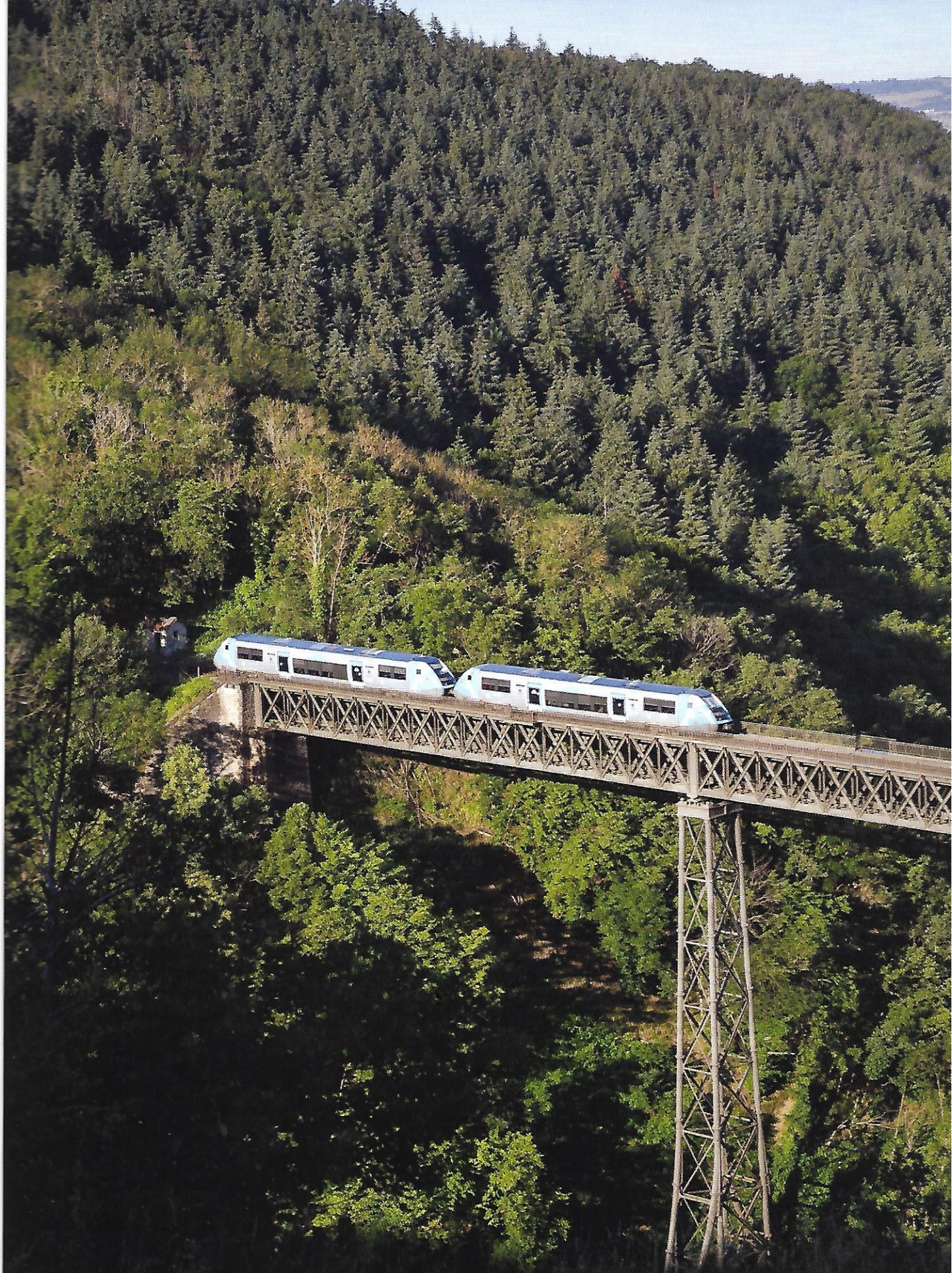
Le viaduc du Belon sur la ligne Commentry-Gannat.
