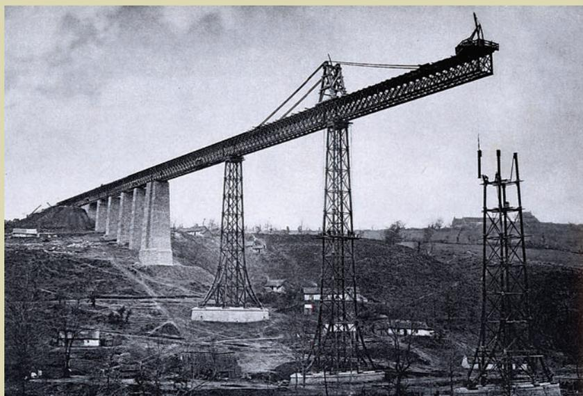
La photo illustre parfaitement les techniques originales utilisées pour construire les parties métalliques de l'ouvrage.
