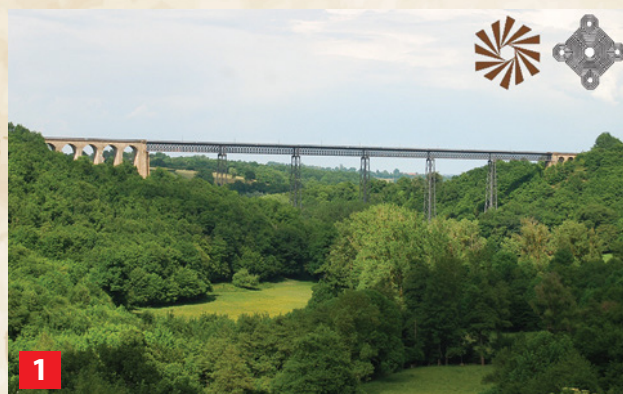
Viaduc de la Bouble
