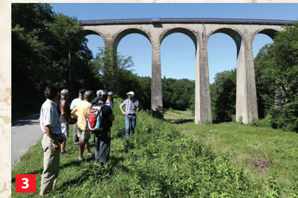
Viaduc de la Perrière
