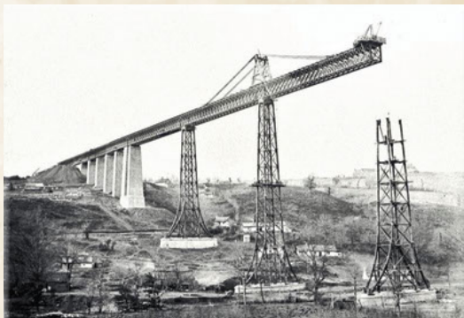
Le viaduc de la Bouble
