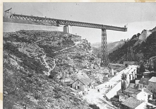
Le viaduc de Rouzat
