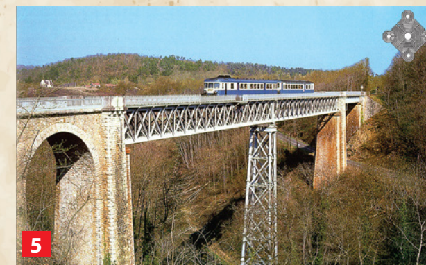
Viaduc de Neuval
