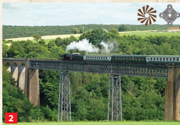
Viaduc du Bélon
